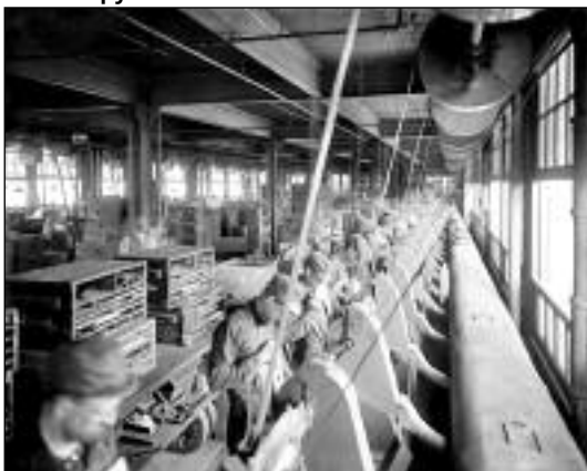
Шлифовально-полировальные станки, цех с плоскоремненным приводом от трансмиссии. Начало XX в., США. Как видно, на станках уже появилась групповая вытяжка
