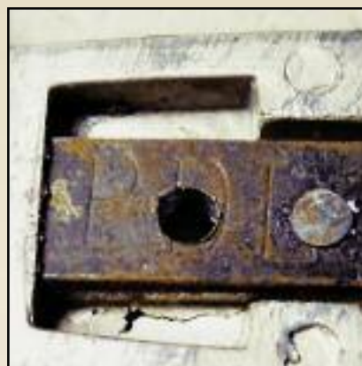
Фото 15. Крючок на лицевой поверхности ножен для зацепления в лопасти подвески
