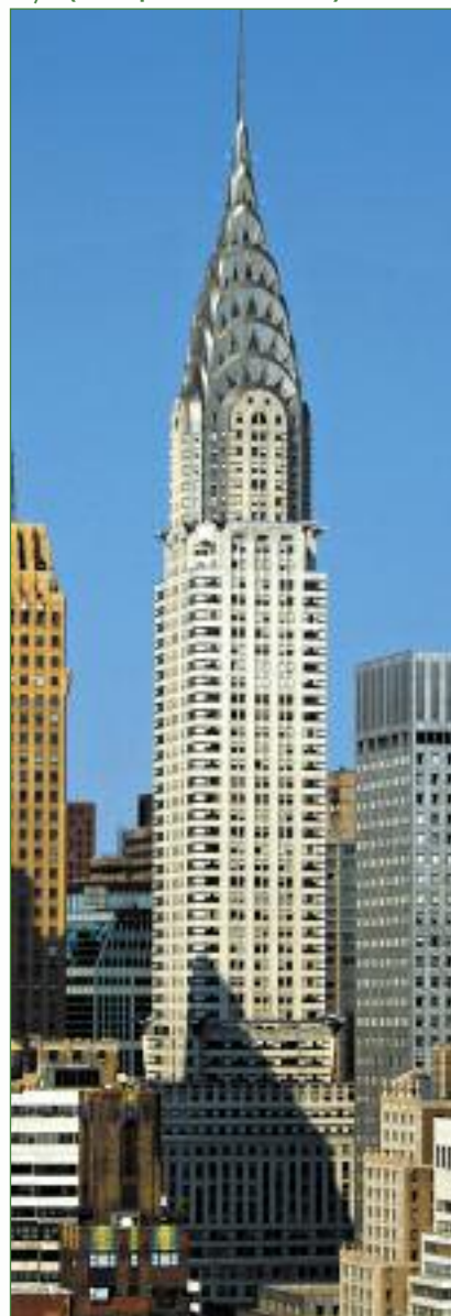
«Крайслер-билдинг» — 319-метровый небоскреб корпорации Chrysler, построенный в 1930 г., являющийся одним из символов Нью-Йорка. Здание увенчано уникальным 38-метровым шпилем, изготовленным в 1929 г. из нержавеющей стали Nirosta марки 18/8 (18% хрома, 8% никеля)
