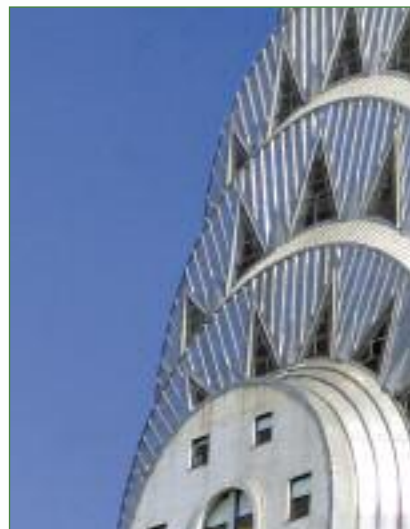
«Крайслер-билдинг» — 319-метровый небоскреб корпорации Chrysler, построенный в 1930 г., являющийся одним из символов Нью-Йорка. Здание увенчано уникальным 38-метровым шпилем, изготовленным в 1929 г. из нержавеющей стали Nirosta марки 18/8 (18% хрома, 8% никеля)
