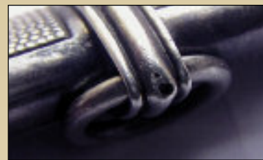
Фото 19. На гайке поддельных ножен офицерского кинжала TeNo хорошо видна огромная раковина
